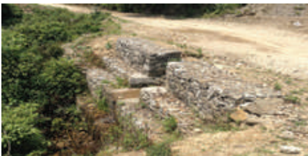
चेक ड्याम (Check Dam)
